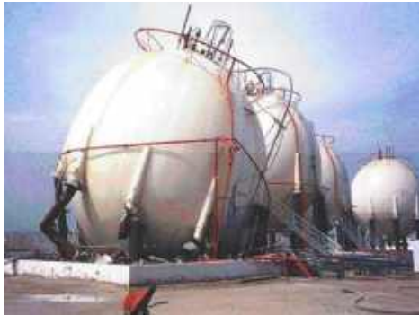
Рисунок 4. Резервуары с СПГ.
